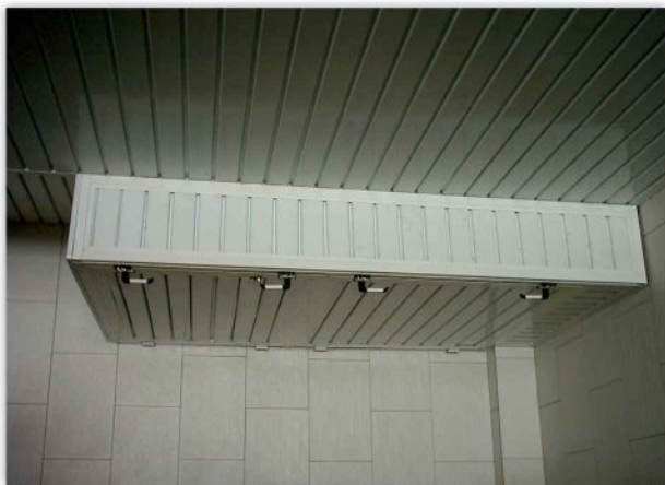
نصب در سقف کاذب
