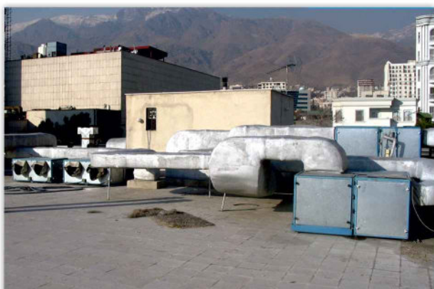
نصب در پشت بام
