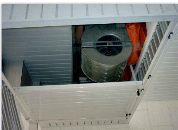
نصب در سقف کاذب
