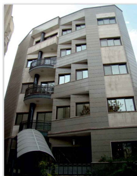
پروژه الهی ۱۰ واحد مسکونی
